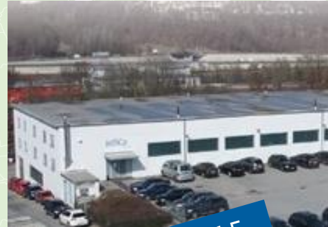
Technologiezentrum Passau (D)
