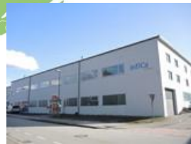
Technologiezentrum Passau (D)
