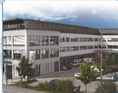
Passau, Deutschland Zentrale & Technologiezentrum
