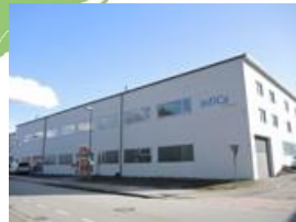
Technologiezentrum Passau (D)
